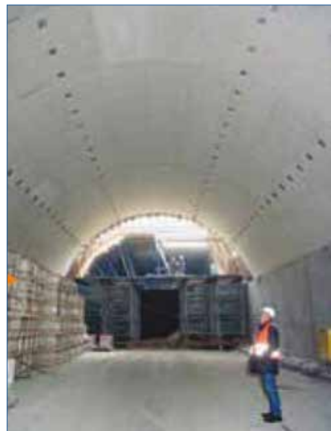
Radovi u toku.
