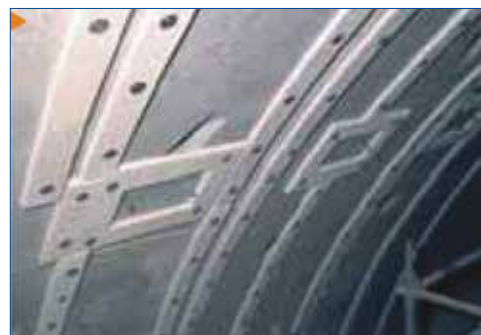
Mali SureHit se koristi za pričvršćivanje protivpožarnih tabli.
