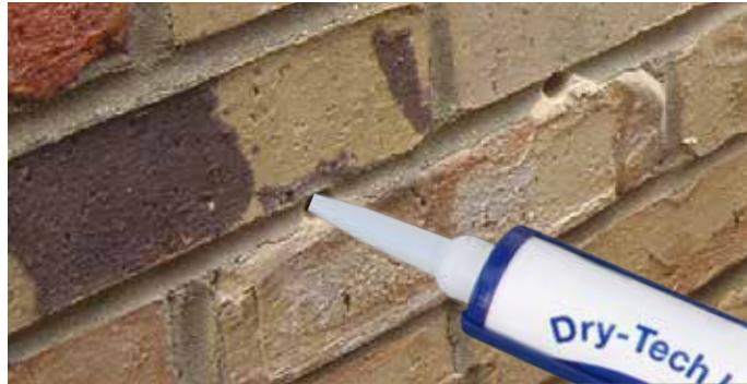
1. Rupe prečnika 12 mm bušiti horizontalno u spojeve maltera na razmaku od 120 mm, do dubine od 10 do 20 mm od suprotne fasade.
