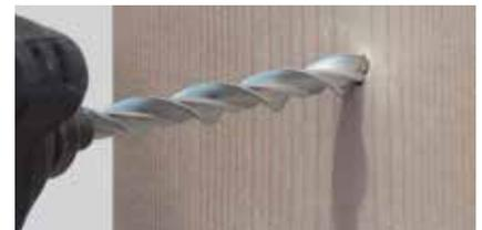
3. Koristeći bušilicu, namestite pričvršćivač sve dok alat za instalaciju ne naleže čvrsto na površinu drvene lajsne.
