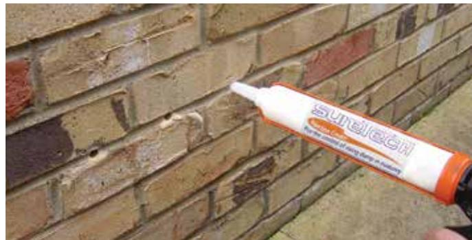
1. Forer des trous de 12 mm de diamètre à l'horizontal dans le joint de mortier, avec 120 mm de distance entre chaque trou et à une profondeur de 10 à 20 mm par rapport au côté opposé.
