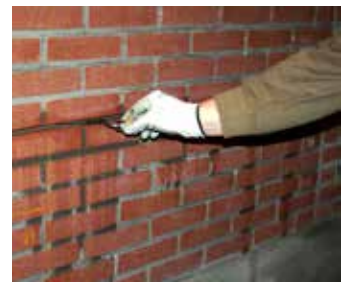
Pousser la barre dans le mortier de scellement puis injecter un autre cordon de mortier de scellement
