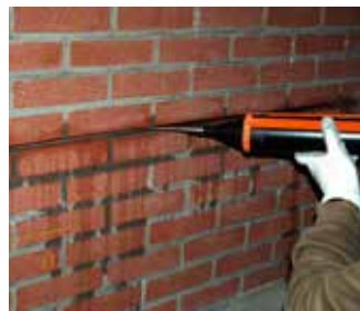
Injecter le cordon de mortier de scellement
